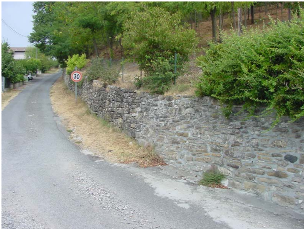
Foto n°13: Particolare del muro a secco che delimita l'area di futura edificazione
