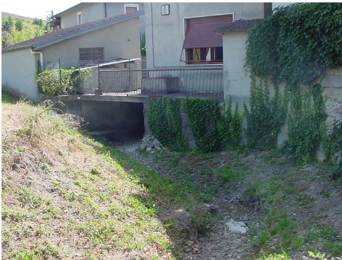
Foto n°33: Particolare del punto in cui il Rio San Gabriele diviene intubato
